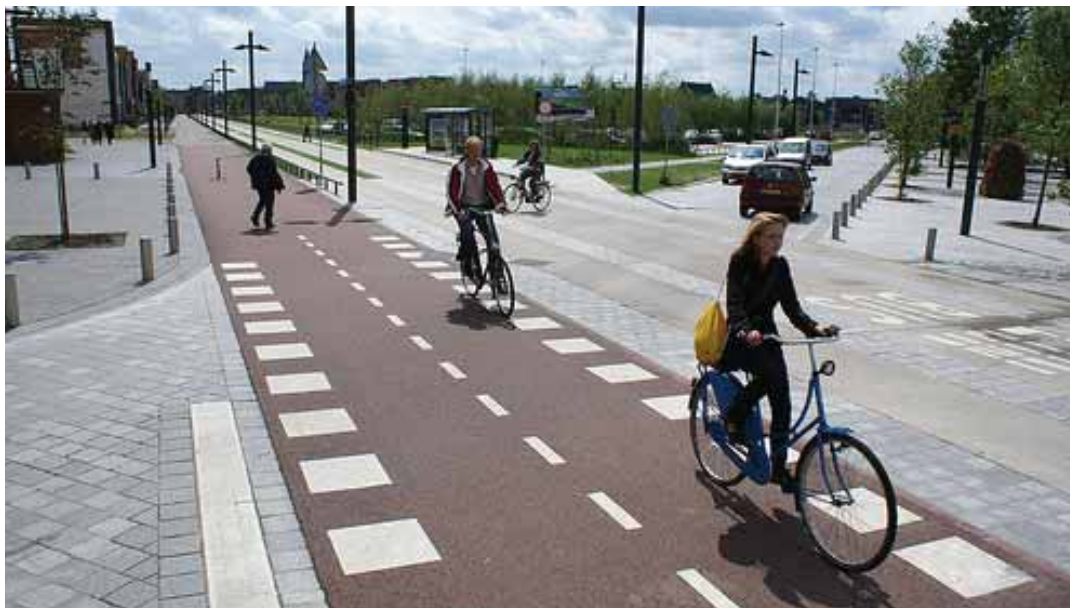
Kruispunt Lonnekerspoorbaan en Roomweg
