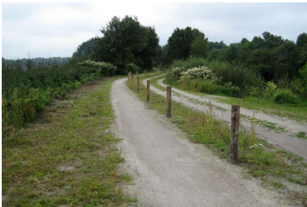
KoMex-fietspad tussen Beilen en Drijber.
