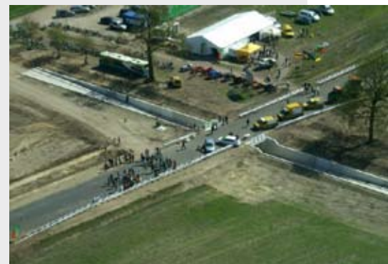
De nieuwe tunnel in de rondweg Wesepe die binnenkort in gebruik wordt genomen.
