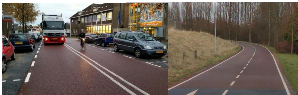
Figuur 8: Lengtemarkering draagt niet bij aan het verblijfskarakter. Bovendien vervaagt hierdoor het onderscheid tussen fietsstraat en fietspad (rechts)
