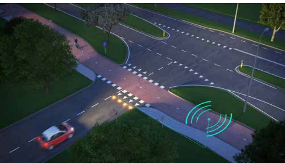
Leds in het wegdek waarschuwen automobilisten bij oversteekplaatsen voor naderende fietsers (Heijmans).
