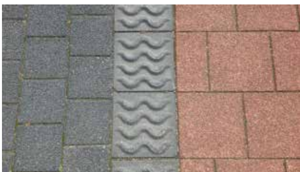
Niet uitvoerig getest maar wel veelbelovend: de ribbelrand.
