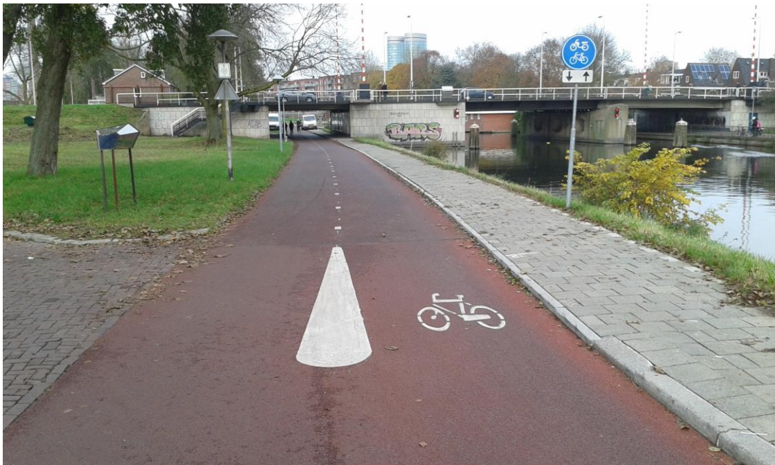
Figuur 1: Op deze locatie in Utrecht waren de palen niet strikt noodzakelijk. Bij een reconstructie zijn ze verwijderd en vervangen door markering
