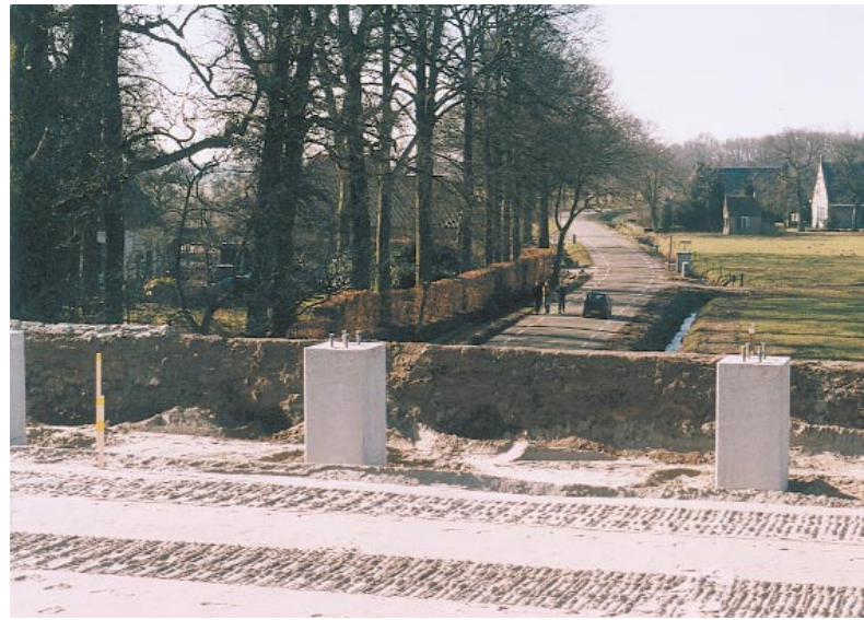
De aanleg van de HSL doorsnijdt de lokale verbindingsweg Breda - Etten-Leur.
