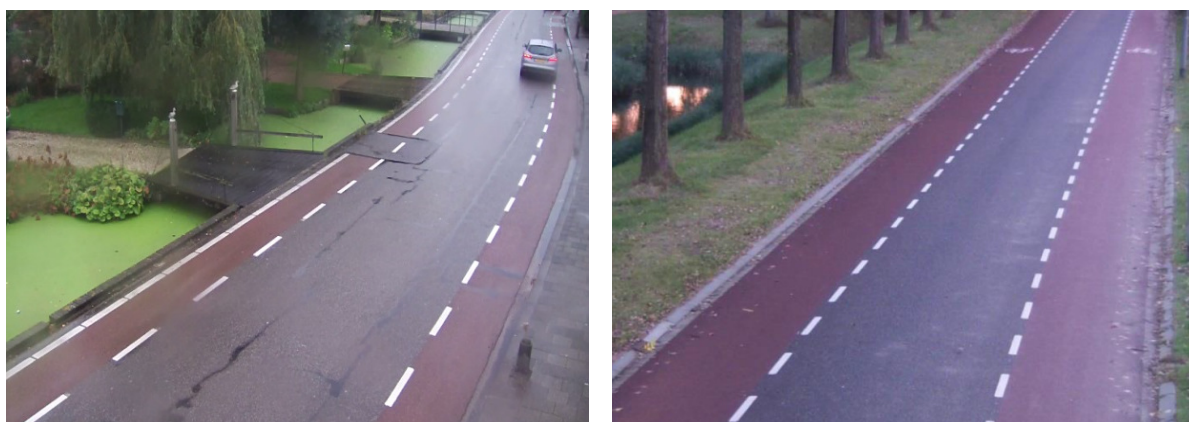
Figuur 5 Links: Smalle fietsstroken en een middenrijloper met onduidelijke breedte. Rechts: Fietsstroken met voldoende breedte en een middenrijloper voor één personenauto
