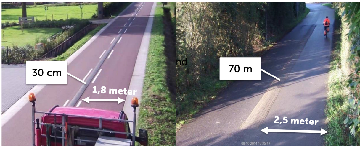
Figuur 8 De twee fietsstraten buiten de kom uit het evaluatieonderzoek. Links in Putten, rechts in Middelburg. Beide fietsstraten hebben een bolbestrate middenas, maar er zijn grote verschillen in de uitvoering. De bolbestrate middenas lijkt relatief veel invloed te hebben op de dwarspositie en de snelheid van passerende auto's. Dit kan echter ook leiden tot meer krappe inhaalbewegingen. De waardering van de fietsers voor de Middelburgse variant (gemiddeld rapportcijfer: 6,8) is hoger dan voor de Puttense variant (6,2). In Putten zijn de meningen opvallend sterk verdeeld: de helft van de ondervraagden geeft een cijfer hoger dan een zeven, bijna veertig procent geeft lager dan een zes. Om verantwoorde conclusies te kunnen trekken is aanvullend onderzoek nodig.
