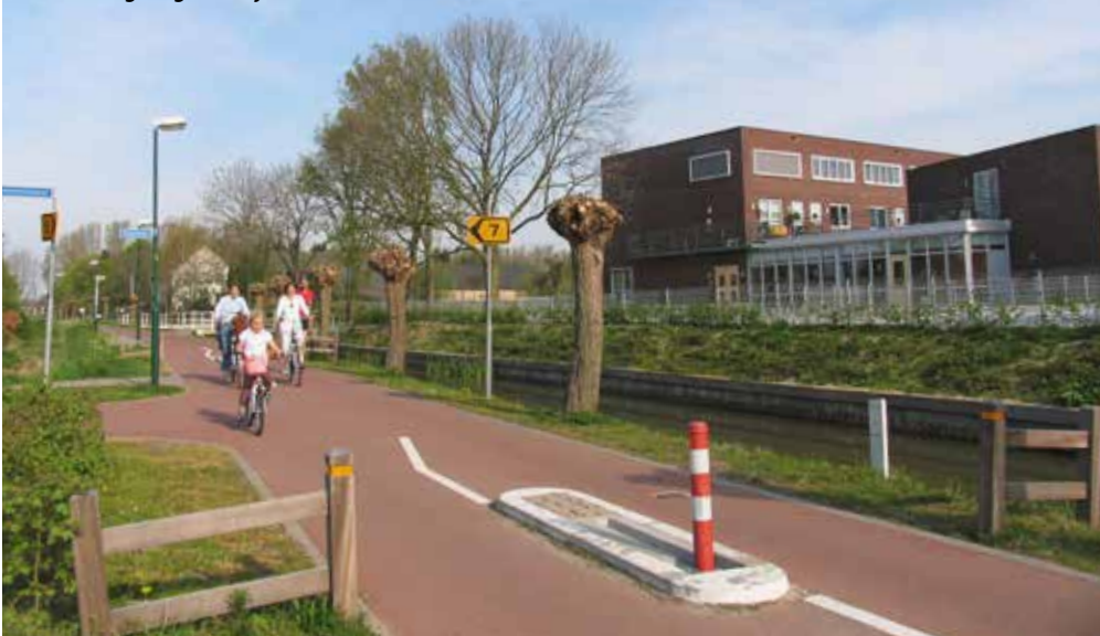
Beeld van de oude situatie in Houten: ontbrekende markering en gevaarlijke betonblokken.
