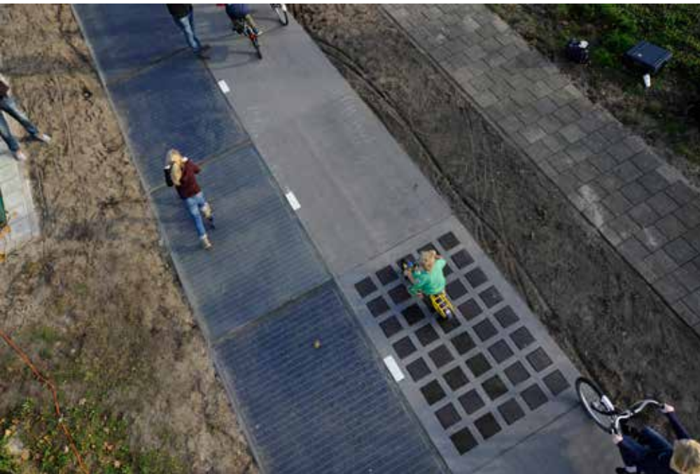
Stroom uit een fietspad. De SolaRoad levert in de pilot elektriciteit voor 2 tot 3 huishoudens.
