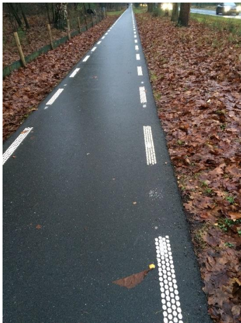
Voorbeeld van een fietspad met DOT-markering (foto: Antea Group)
