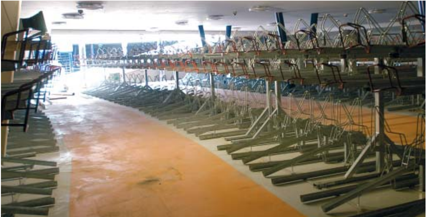
De nieuwe fietsenkelder bij station Zutphen. In de tijdelijke situatie (rechtsboven) is het behelpen.
