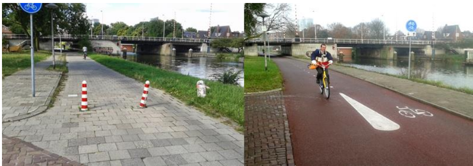
Figuur 1 Voorbeeld van een fietspad met hinderlijke palen (links) en hetzelfde fietspad na reconstructie, waarbij de palen zijn vervangen door markering.
