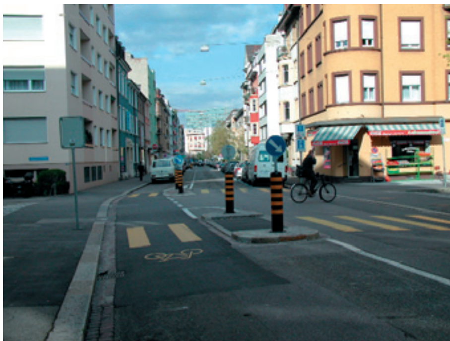
Basel. Verkeerseilanden met een dubbele functie: ze beschermen begin en einde van de fietsstrook bij een kruising en geven voetgangers de mogelijkheid om in twee etappes over te steken.
