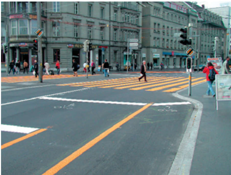
Bern. Hetzelfde punt als hierboven: omgeving Centraal Station. De definitieve herinrichting van het kruispunt: de hermarkering van fietsstroken en opstelvakken, een fietsverkeerslicht met detectielus.
