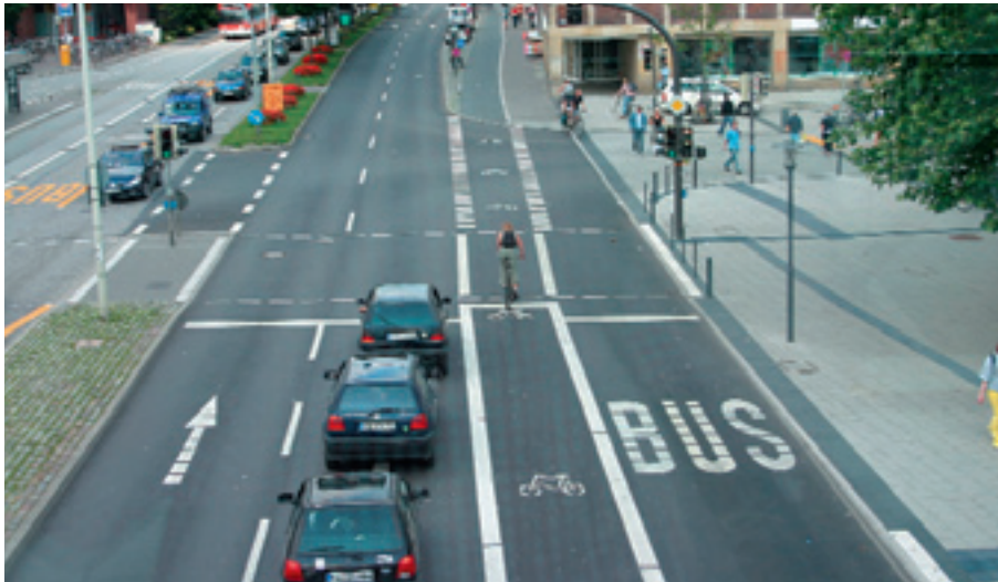
Kiel. Bij de recente herinrichting van het Stationsplein werd het plein verkleind ten bate van een bus- en een fietsstrook. De fietsstrook wordt rechts en links gemarkeerd door middel van een 25 cm brede witte doorgetrokken streep. Voorbij het kruispunt gaat de strook over in een (aanliggend) fietspad.
