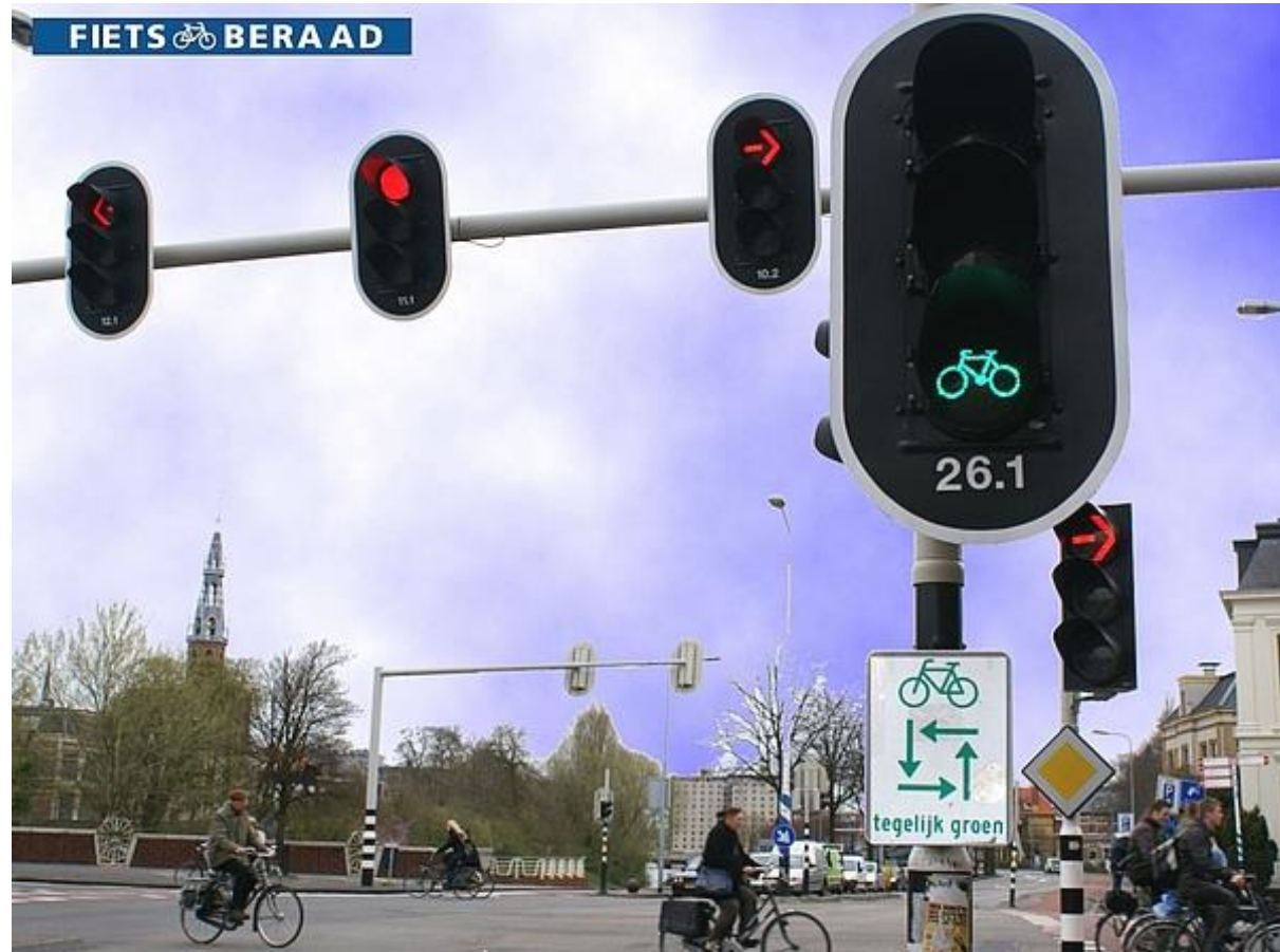
Alle richtingen groen (ARG) Groningen, Herebrug-Zuiderpark
