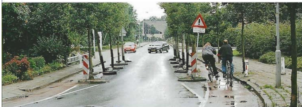
In Ede heeft men de nodige snelheidsremmers aangebracht. Soms zijn de aparte doorgangen voor fietsers naast de drempel of versnellingen aan de nauwe kant.
