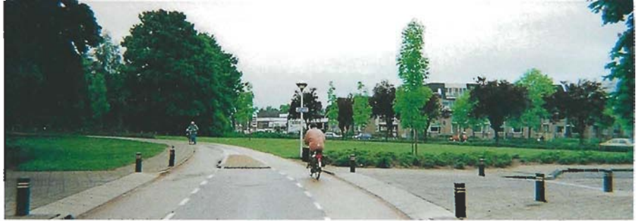
In Raalte is veel werk gemaakt van de vloeiende overgang tussen fietsstroken en fietspad en uitritconstructies voor de zijstraten.
