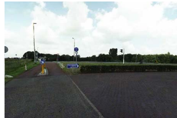
Foto: Parallelweg Spoolderbergweg - Het Engelse Werk
