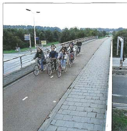
Beijum: fietsbrug over de rondweg.
