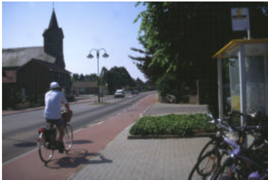
Foto 3.20 Aanliggend verhoogd fietspad – Linde - Peer
