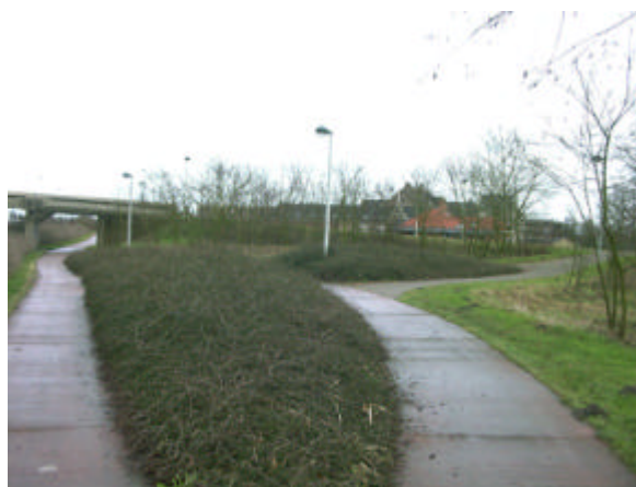
Foto 3.11 Gescheiden fietsvoorzieningen en ongelijkgrondse kruising fietspad - primaire weg - Peer
