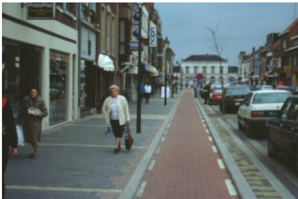
Foto 3.19 Strook tussen vrijliggend fietspad en parkeerstrook – Leopoldsburg
