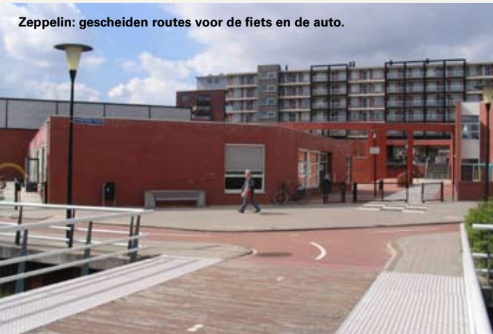
Krullebaar: school met een autovrije zone.
