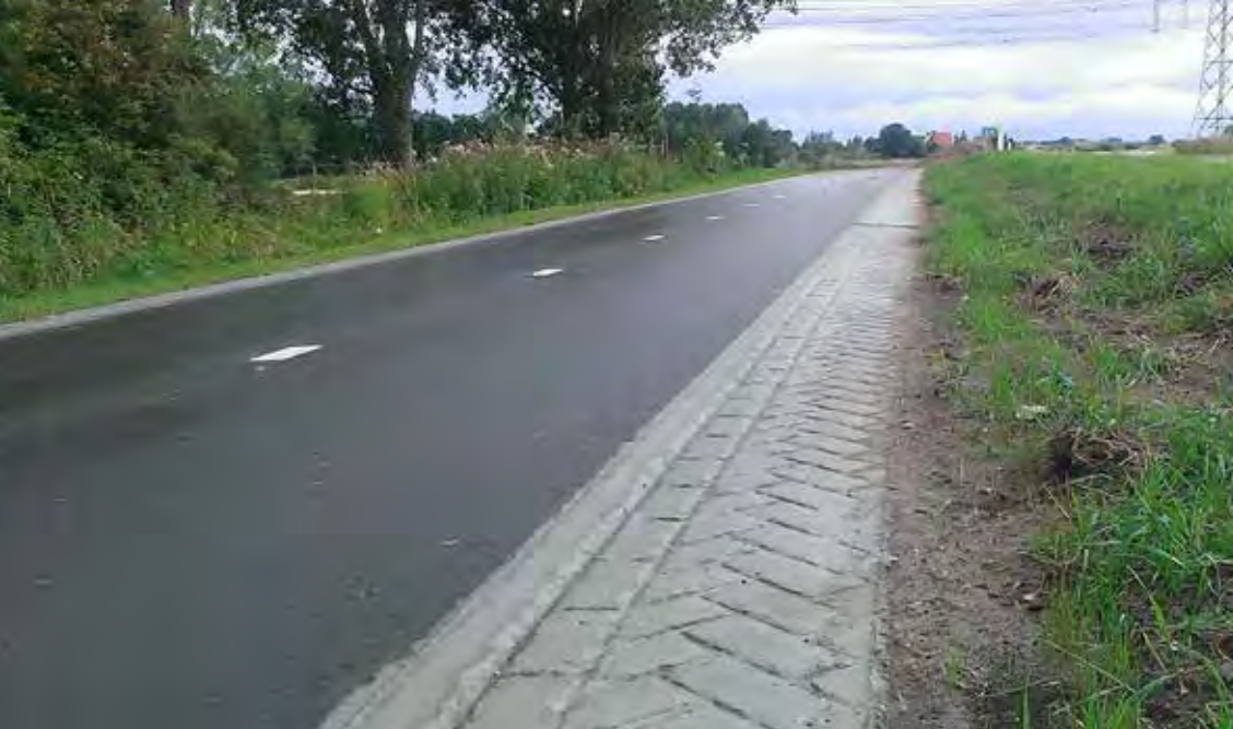
Een betonnen bermverharding (met streetprint) werkte op de proeflocatie het beste. Het biedt de fietser de mogelijkheid te corrigeren als hij in de berm belandt.
