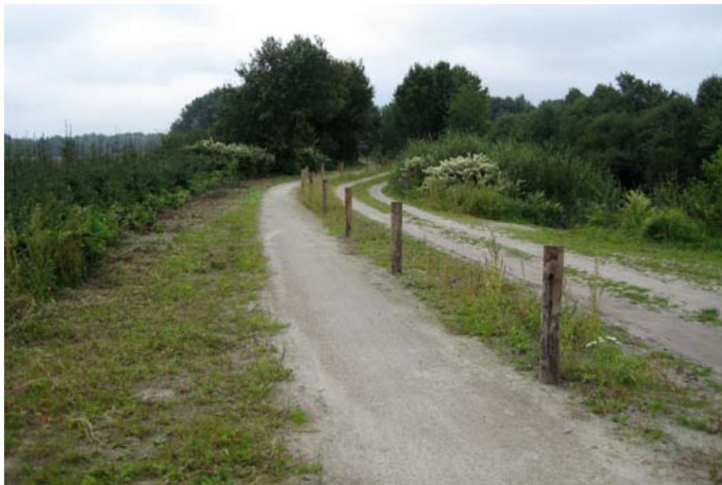
KoMex-fietspad tussen Beilen en Drijber.
