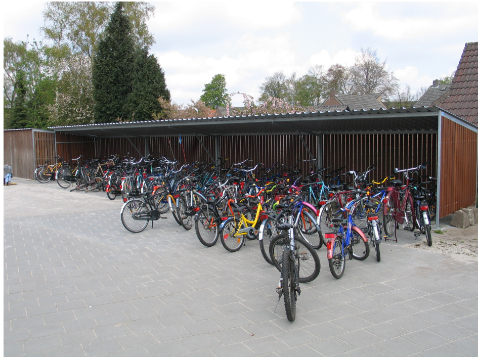
Overkapping te klein, ruimte wordt niet efficiënt gebruikt
