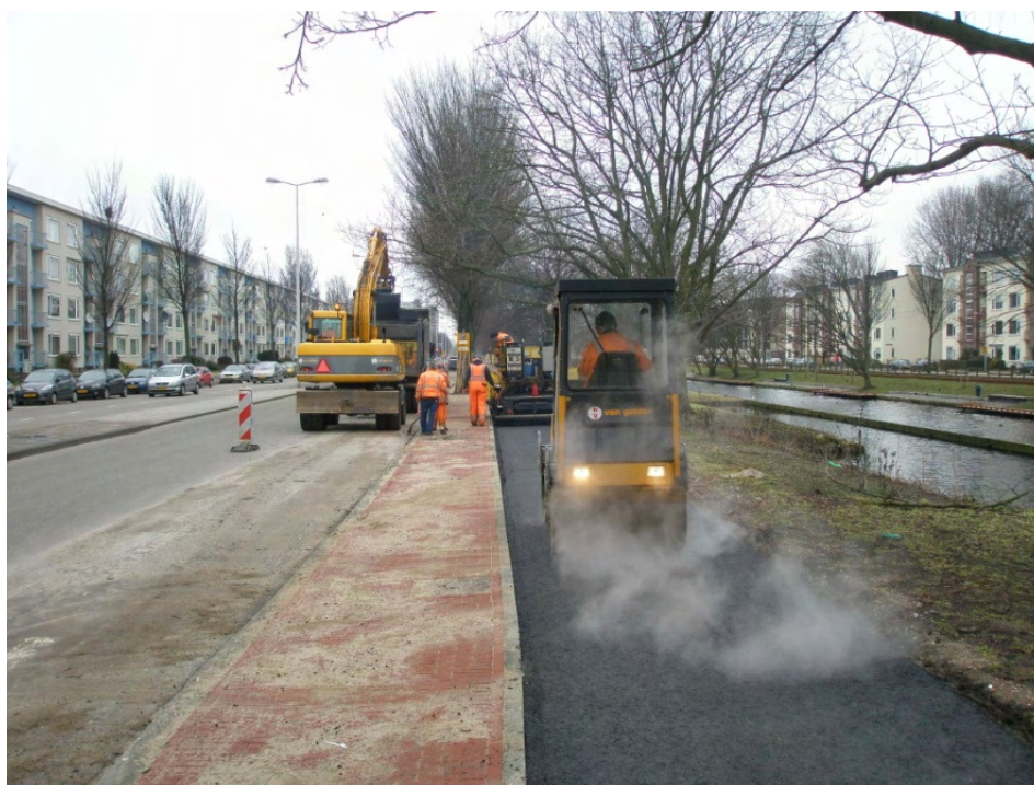
Figuur 14: een door Haaglanden gesubsidieerd project in uitvoering.
