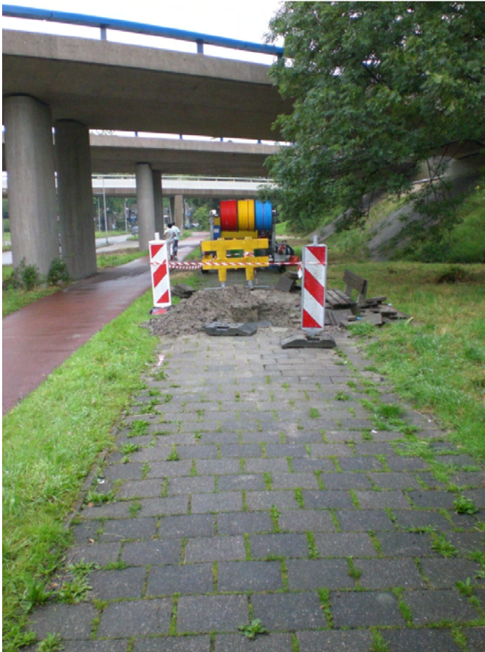
Figuur 4: door kabels en leidingen onder het trottoir aan te brengen, is het nog eenvoudiger om een fietspad in rood asfalt uit te voeren.
