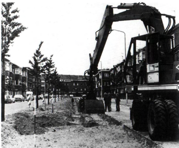
foto 21: op de Mient behoefde slechts het asfalt ter plaatse van de toekomstige veiligheidstrook annex parkeerstrook te worden uitgebroken.
