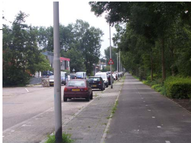
Figuur 4. Een goede keuze voor een tweerichtingsfietspad langs de Vulcanusweg in Delft richting station Delft-Zuid: verkeer voor het bedrijventerrein komt niet in conflict met fietsers; aan de zijde van het verblijfsgebied waar het fietspad ligt zijn er geen zijwegen
