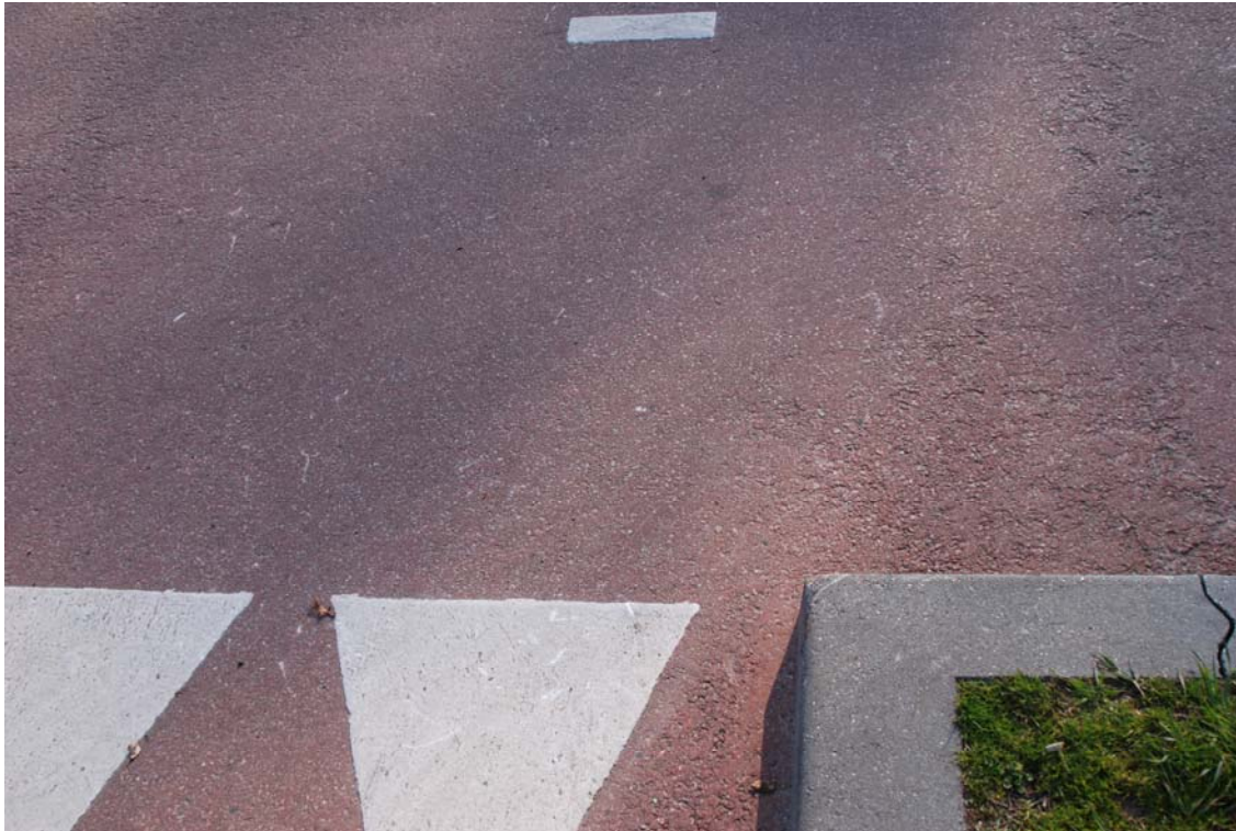
Figuur 1: Haakse hoek op kruispunt van twee fietspaden. Zo moet het dus niet.
