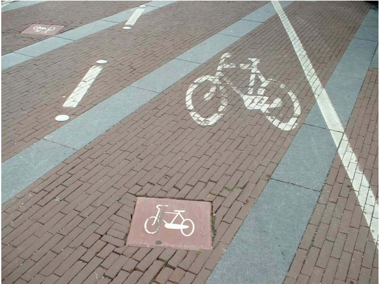
Foto 1/ Fietsroute over Museumplein in Amsterdam. Oorspronkelijk werd de route alleen gemarkeerd door metalen doppen en fietstegels. Dat bleek niet voldoende omdat de natuurstenen randen beter zichtbaar waren en een andere richting suggereerden. Het probleem is opgelost met verfstrepen. Foto Berry den Brinker, Stichting SILVUR
